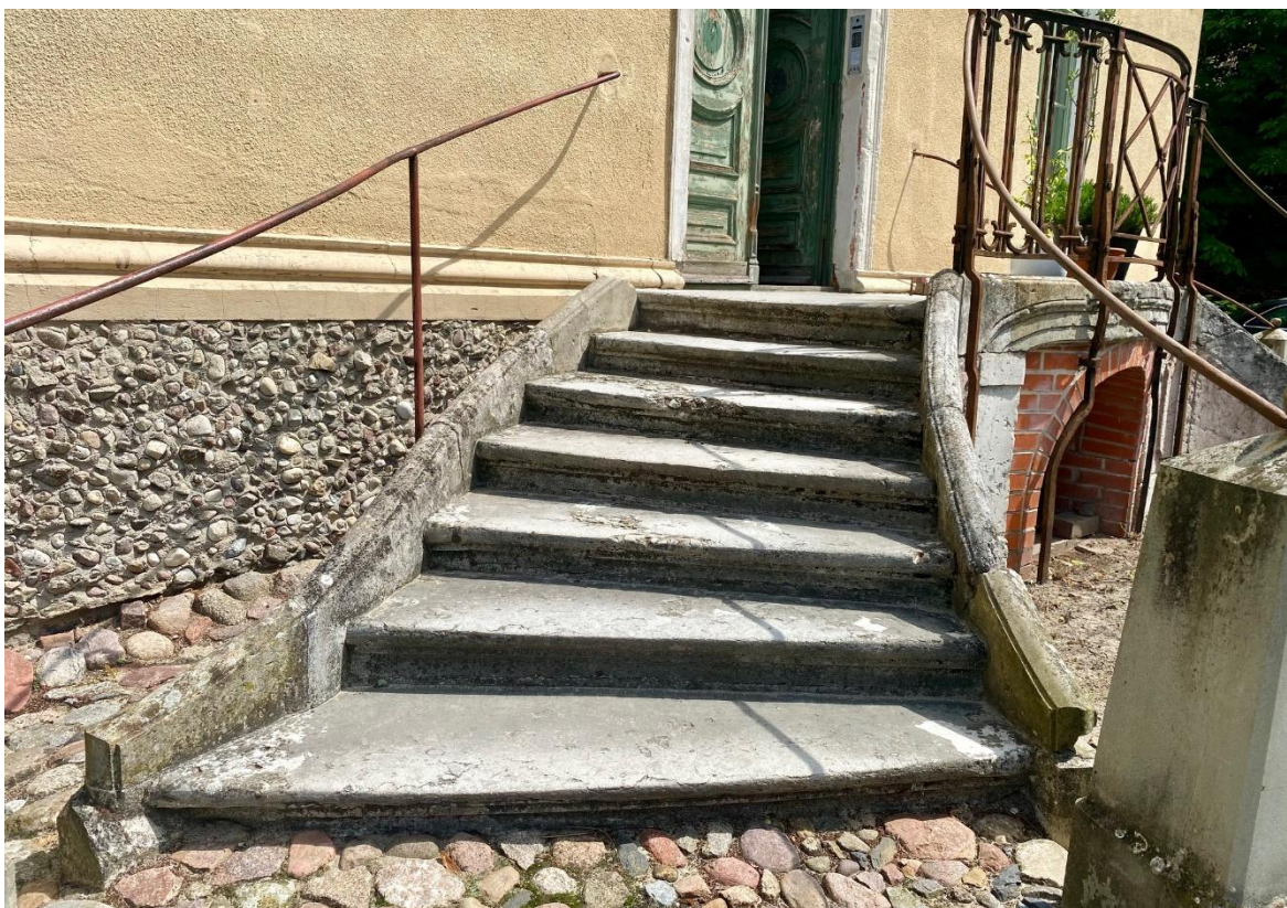
Ilustracja 13 Wejście główne, uszkodzenia schodów.
