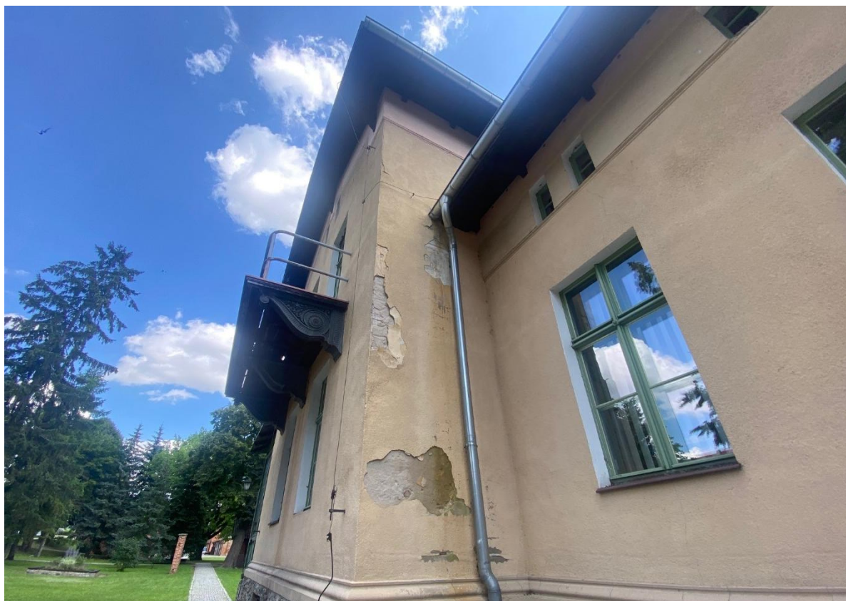
Ilustracja 15 Uszkodzenia tynków zewnętrznych.
